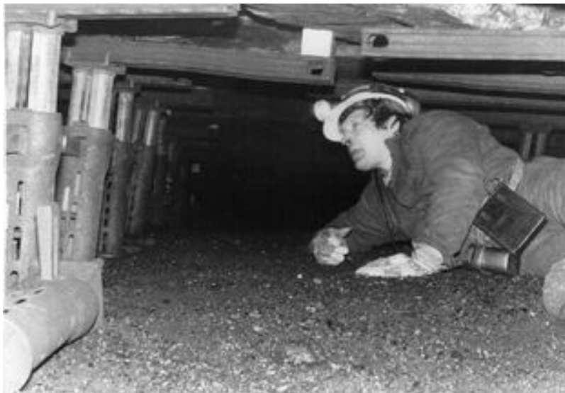
Eg fikk vere med heilt inn på stuffen i Gruve 3, der det er bare 60 cm mellom heng og ligg. Både eg og fotoapparatet var ganske fullt av kolstøv før eg kom ut igjen. Frista ikkje som arbeidsplass! Foto: SL
